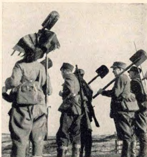
Fortwährend werden die Befestigungen der Mannerheim-Linie noch ausgebaut und vergrößert
